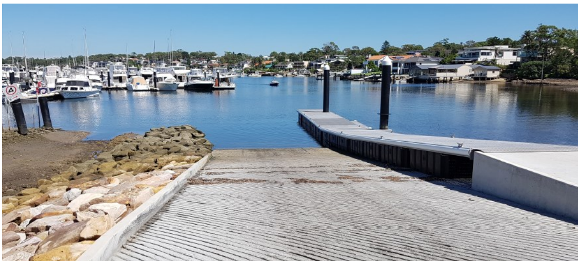
Figura 1 – Rampa náutica Fonte: Sutherland Shire (c2021).
