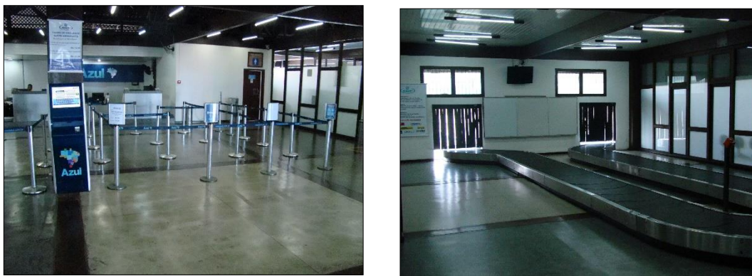
Figura 10 – Áreas destinadas ao check-in convencional (à esquerda) e à restituição de bagagens (à direita) do Aeroporto de Porto Seguro Elaboração: LabTrans/UFSC (2016)
