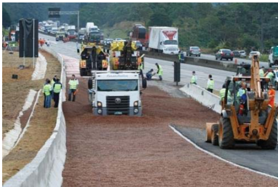
Figura 6: Área de escape no km 671,7 da rodovia BR-376/PR
