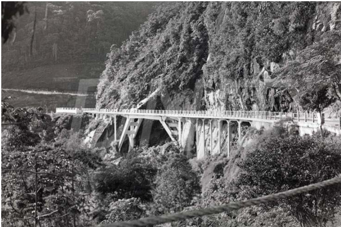
Figura 38: Memórias Fotográfias da infraestrutura do DNER/DNIT (1)
