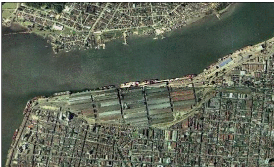
Foto 7 – Área para Granéis Sólidos de Origem Vegetal e Mineral, Líquidos de Origem Vegetal, Contêineres e Carga Geral
