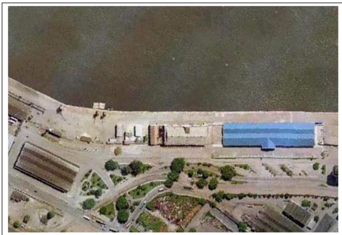
Foto 7 – Área para Terminal de Passageiros
