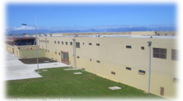
Carcel Penitenciario - Puerto Montt
