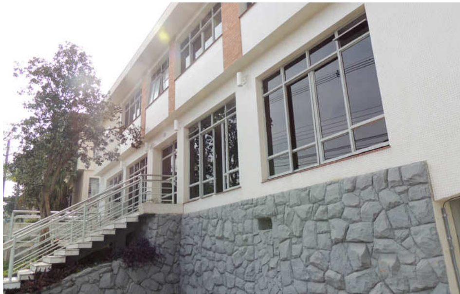
Nova instalação da Unidade Regional Curitiba - URCUB. cedida pela UFPR
