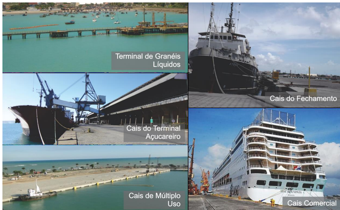
Figura 2 – Trechos de Cais do Porto de Maceió Fonte: Plano Mestre do Porto de Maceió (2015)
