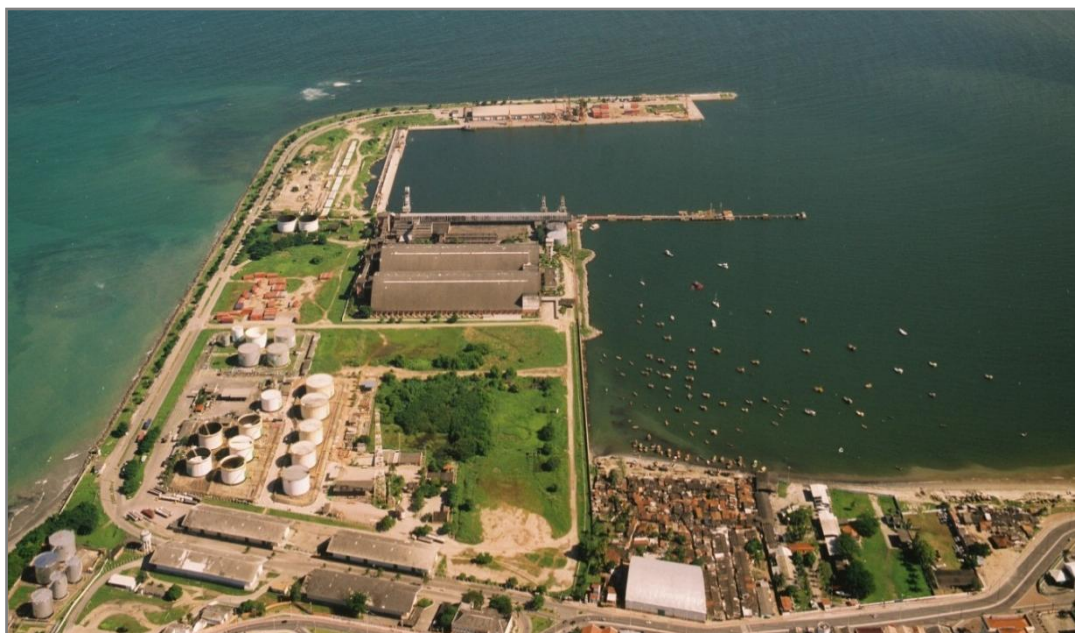
Figura 8: Vias internas do porto de Maceió Fonte: PDZ Porto de Maceió
