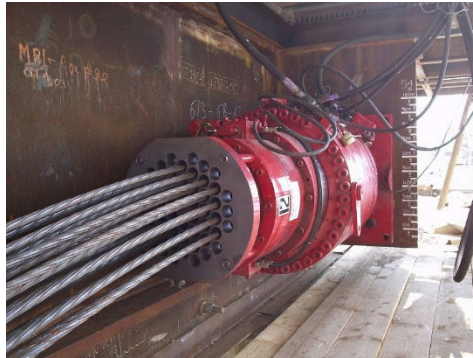
Figura 6 – Strand jack utilizado horizontalmente 4 .
