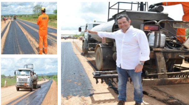
ORDEM DE SERVIÇO PARA INÍCIO DAS OBRAS DE PAVIMENTAÇÃO DA BR-316 - TRECHO CARIÉ/AL – INAJÁ/PE ALAGOAS/AL (15/07/2016)
