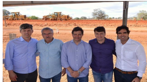
VISITA A OBRA DE PAVIMENTAÇÃO DA BR-135/BA, ENTRE COCOS E A DIVISA BA/MG (28/07/2017)
