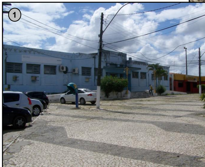
Entrada da Estação Alagoinhas
