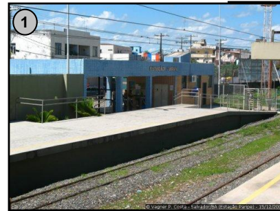
Plataforma da Estação Paripe
