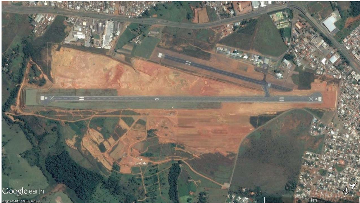
Figura 3 - Imagem via satélite do Aeroporto de Anápolis Fonte: Google Earth (2016). Elaboração: LabTrans/UFSC (2018)
