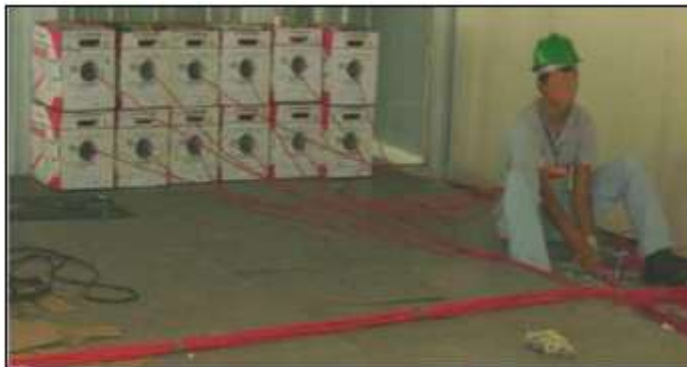
Figura 37 – Método de Lançamento de Cabos.
