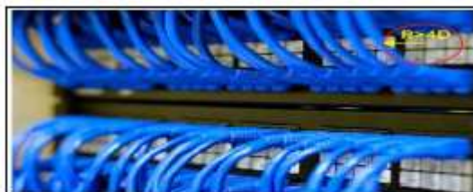
Figura 19 - Raio Mínimo de Curvatura para Cabo UTP.
