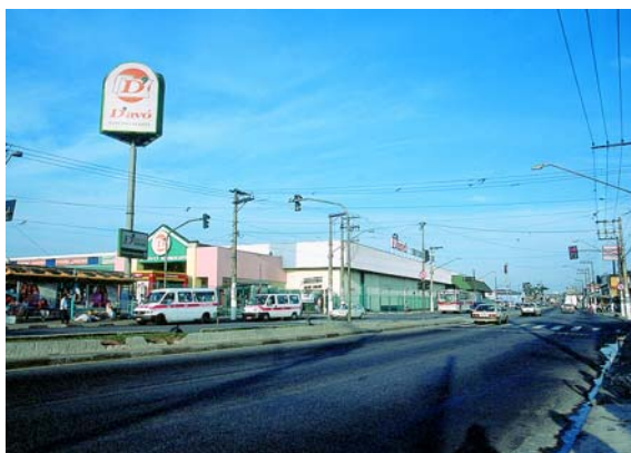
EMPREENHIMENTO: Supermercado D'avó , São Paulo / SP SERVIÇOS: Sinalização semafórica; colocação de faixa de pedestre; construção de alça de acesso ao viaduto china
