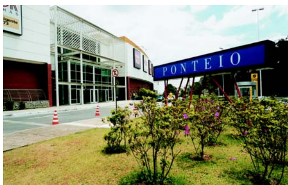
EMPREENDIMENTO: Ponteio (Shopping especializado em decoração e design), Belo Horizonte / MG SERVIÇO: Via de acesso ao estacionamento interno separada da via principal
