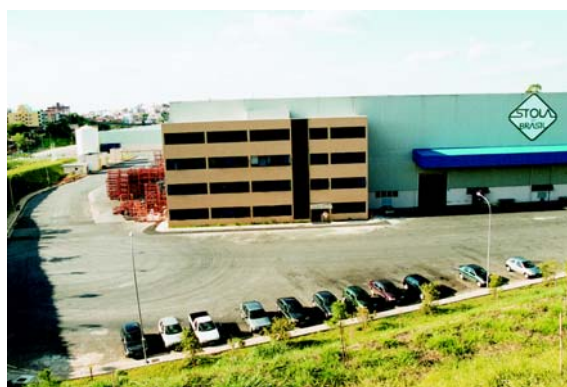
EMPREENHIMENTO: Stola Brasil / FIAT, Montadora de veículo, Belo Horizonte / MG SERVIÇOS: Implantação de via de circulação interna na área da fábrica
