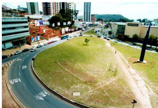
EMPREENDIMENTO: BH Shopping, Belo Horizonte / MG SERVIÇOS: Rotatória para canalização dos fluxos de acesso ao empreendimento e ao bairro como um todo
