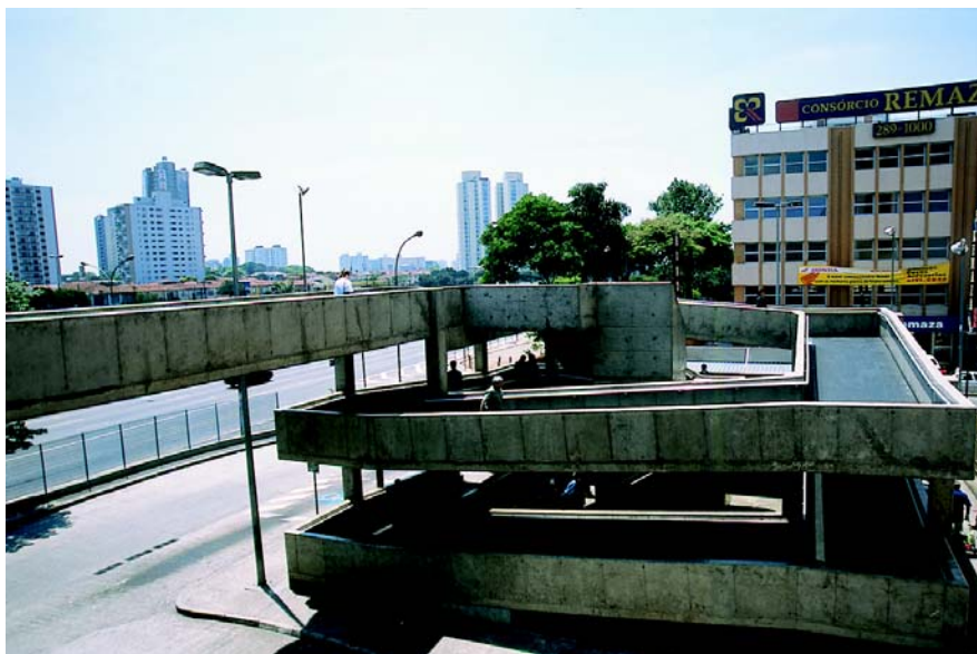
EMPREENHIMENTO: Shopping Metrô-Tatuapé, São Paulo / SP SERVIÇO: Adequação do acesso à passarela de pedestre, ligando a estação do metrô ao shopping
