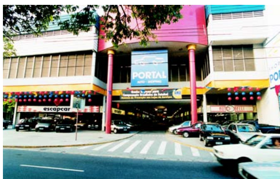
EMPREENDIMENTO: Portal Auto-Shopping (Shopping especializado em automóveis), Belo Horizonte / MG SERVIÇOS: Adequação do acesso interno ao shopping; tratamento da travessia de pedestre
