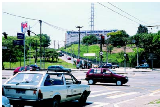
EMPREENHIMENTO: Shopping Metrô-Tatuapé, São Paulo S/P SERVIÇOS: Implantação da passarela para pedestres (ligando a estação do metrô ao shopping); alça de acesso ao Shopping Metrô-Tatuapé, pela Av. Alcântara Machado; alargamento da via (Av. Tuiuti), lado direito
