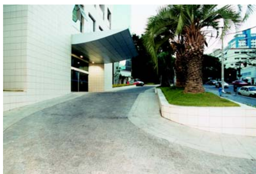
EMPREENDIMENTO: Life Center (Complexo Médico Hospitalar Vertical), Belo Horizonte / MG SERVIÇOS: Área especial para embarque e desembarque de clientes fora da via pública
