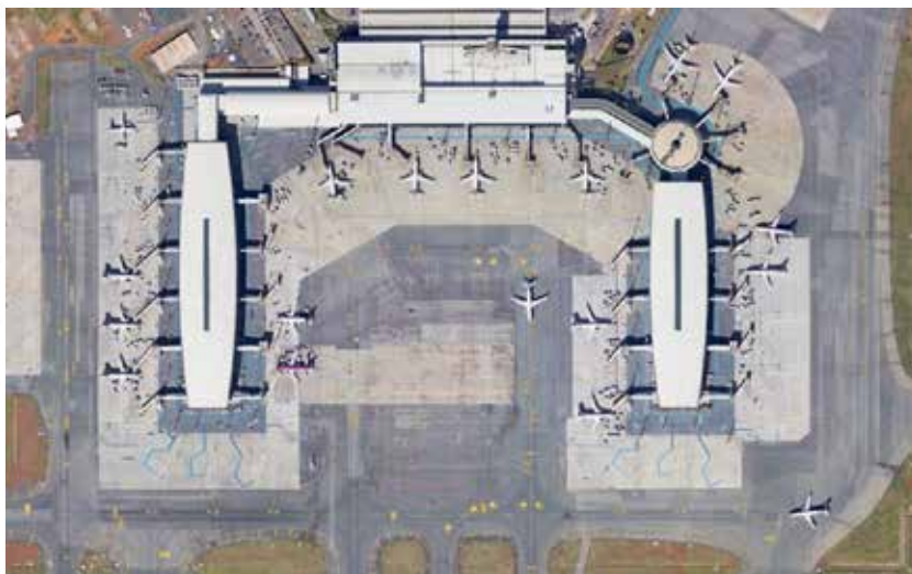
Figura 2-11: Exemplo de pátio de estacionamento de aeronaves – aeroporto de Brasília - DF (fonte: Google Earth)
