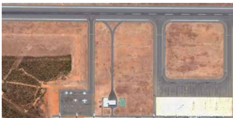
Figura 2-18: Exemplo de SCI e acesso de emergência direto à PPD (centro da imagem)
