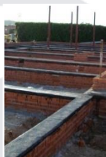
Serviços de impermeabilização
