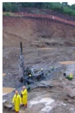
Escavações, fundações e desmonte de rochas
