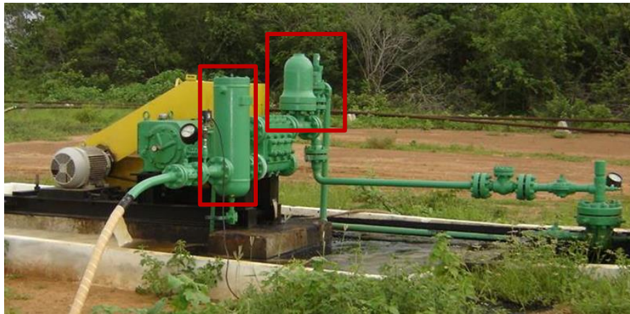
Figura 8 – Vasos amortecedores de fluido principal de bomba
