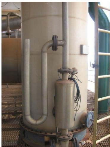
Figura 17 – Proteção contra vácuo utilizando um sifão
