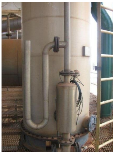
Figura 17 – Proteção contra vácuo utilizando um sifão
