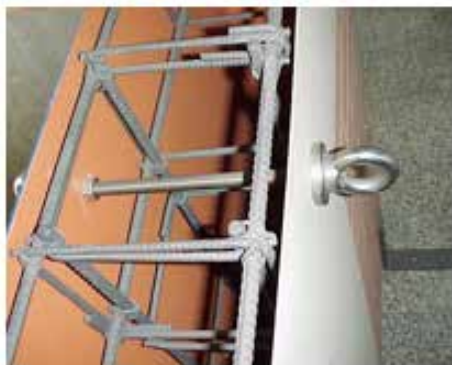
instalação dentro de viga de concreto
