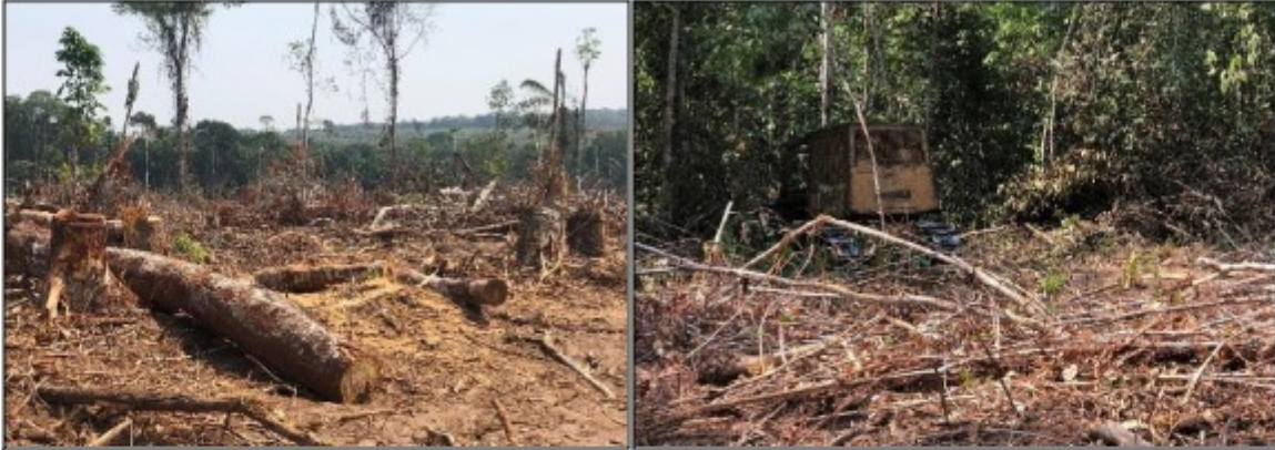
Fotos 21 e 22: frente de trabalho de supressão vegetal.
