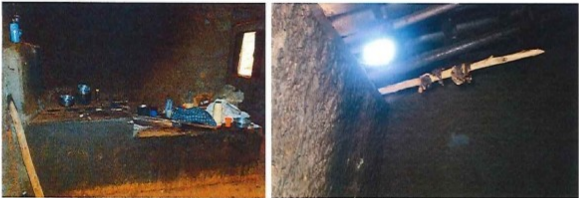
Sem energia elétrica no local, não havia meios adequados de conservar alimentos perecíveis
