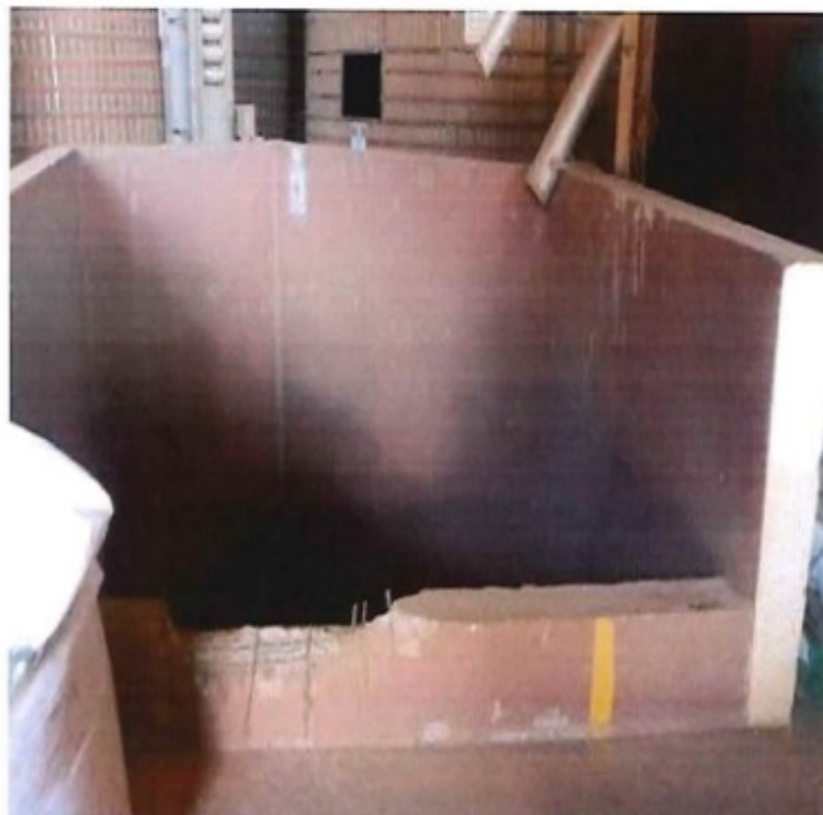
Fosso de elevador desprotegido, expondo a risco de queda os trabalhadores que ali laboram
