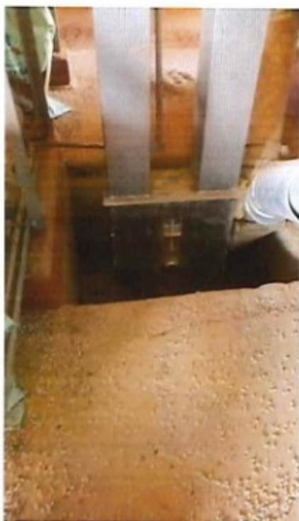
Fosso de elevador desprotegido, expondo a risco de queda os trabalhadores que ali laboram
