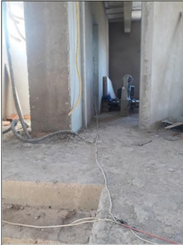
Fotos: Instalações elétricas improvisadas interior do alojamento.
