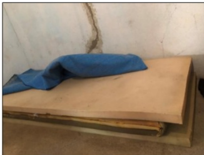
Foto 7: espumas utilizados pelos trabalhadores para dormir, colocadas diretamente no piso do alojamento.
