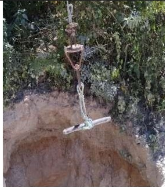
Tipo de cadeira suspensa improvisada para transportar os trabalhadores
