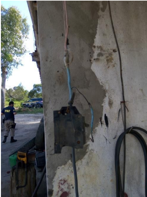
Fiação sem proteção - risco de choque elétrico
