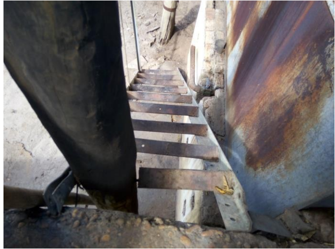
Escadas fora das especificações técnicas da ABNT
