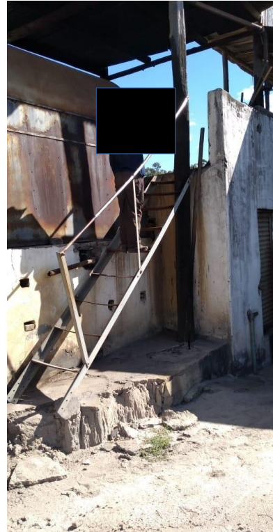
Escada de acesso ao piso superior
