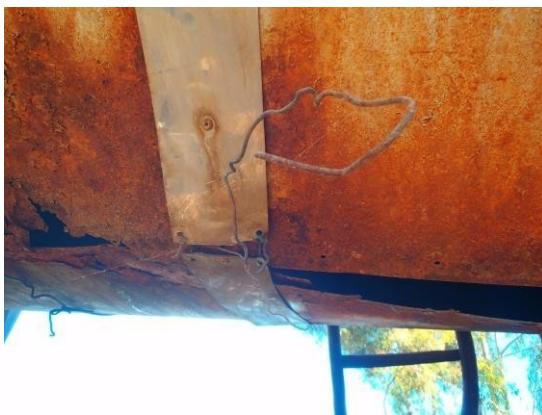
Partes deterioradas na estrutura da caldeira
