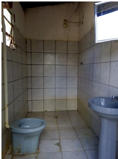
Detalhe do único sanitário existente no local
