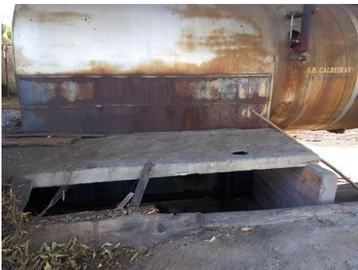
Risco de quedas em buraco no piso e inexistência de guarda-corpo em altura
