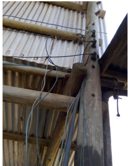
Fiação sem proteção - risco de choque elétrico
