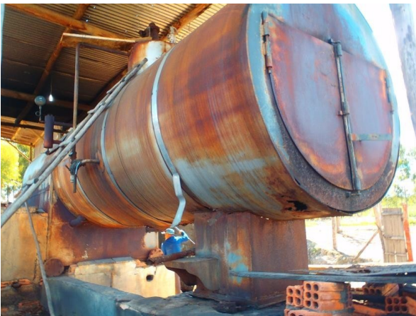
Detalhe da caldeira existente na usina
