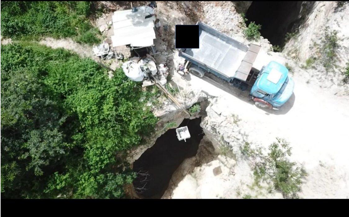
Caminhão sobre um vão escavado sem critérios técnicos atestando a estabilidade.
