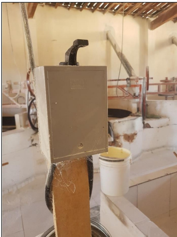
Fotos: Disjuntores e chaves reversoras eram utilizados para acionar as máquinas da casa de farinha.
