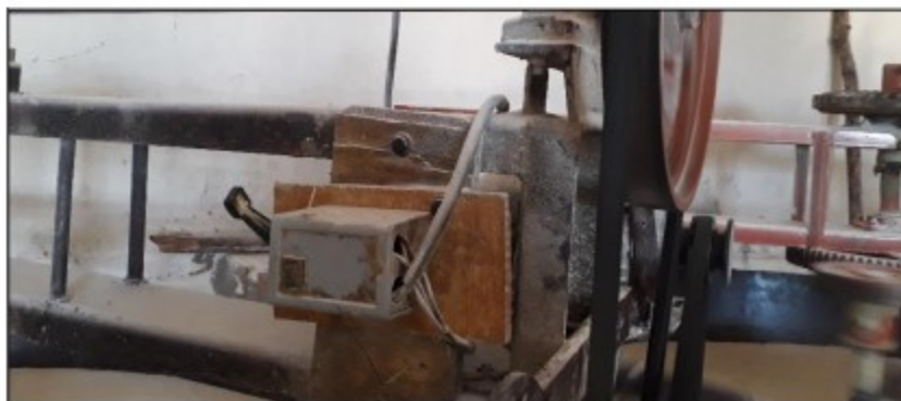
Foto: Dispositivo de acionamento localizado em zona perigosa de um dos fornos
