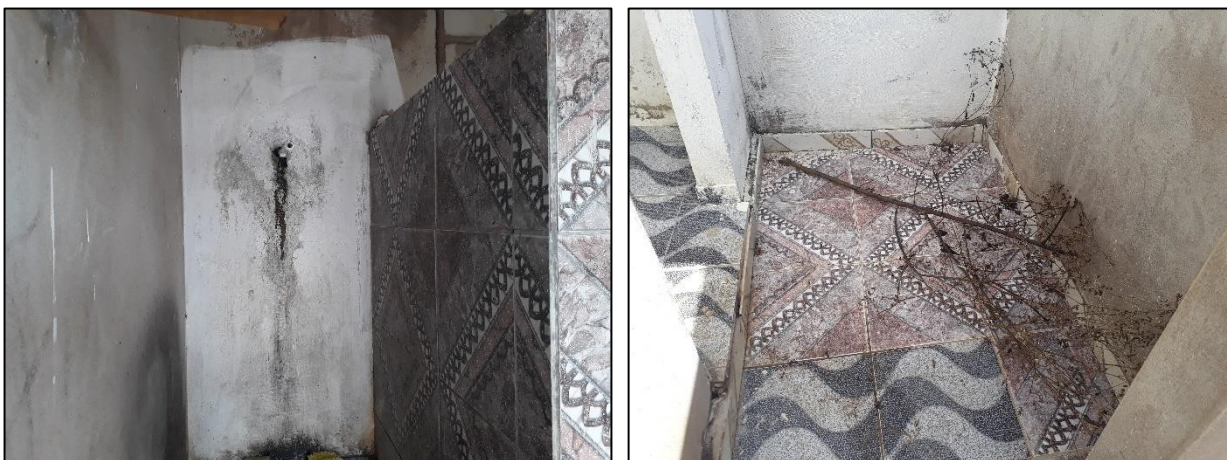
Fotos: Instalações sanitárias da casa de farinha.
