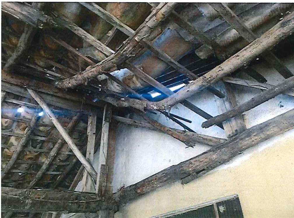
**Telhado com risco de desabamento**
