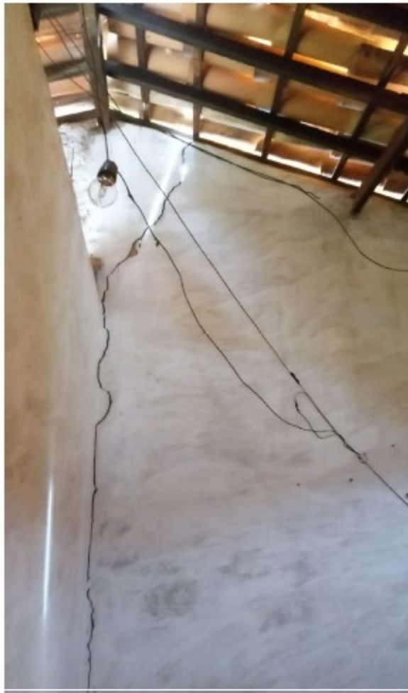
Fiação sem proteção causando risco de choque elétrico
