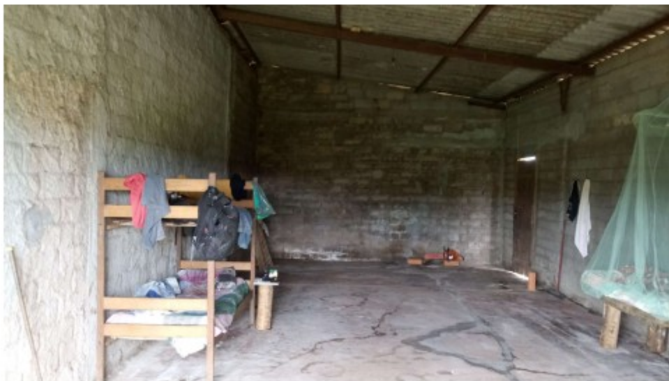
Interior do galpão sem janelas, ao fundo a outra porta, que ficava trancada
