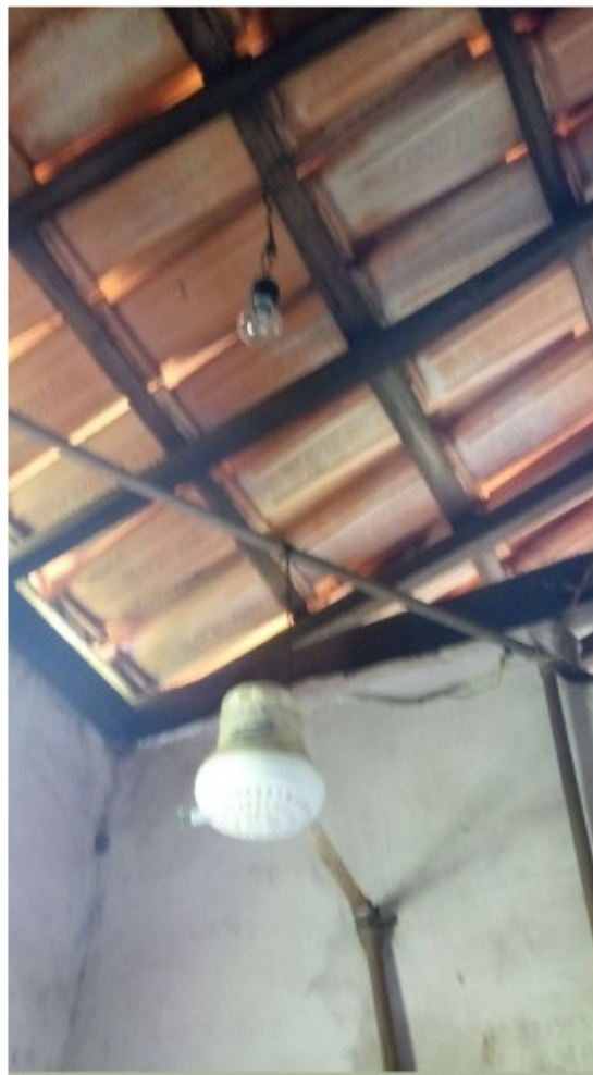
Fiação sem proteção causando risco de choque elétrico
