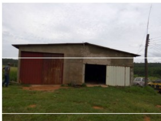
Galpão usado como alojamento
