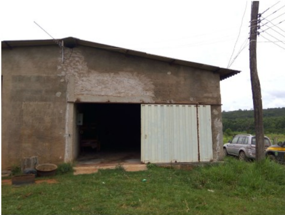
Porta do galpão improvisado com alojamento, que fica aberta para garantir ventilação
