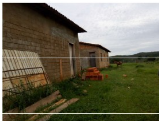
Galpão e casa próximos à sede
