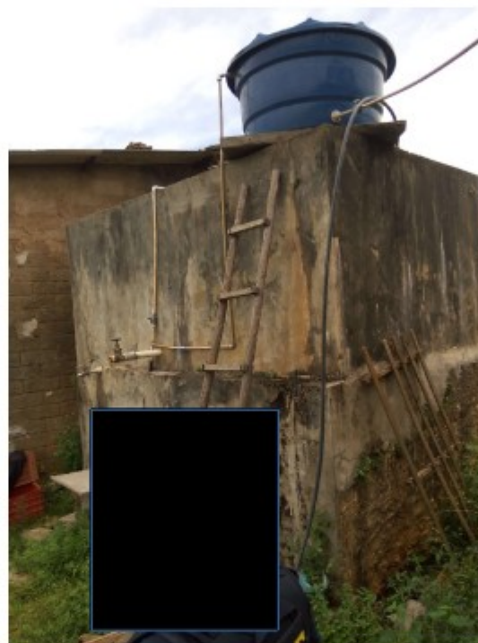
Caixa água do alojamento próximo à sede da fazenda
