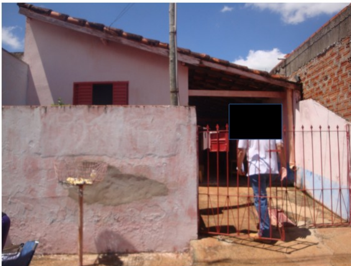
12/03/2019 - chegada da equipe de Auditores-Fiscais no ALOJAMENTO 2, situado na [REDACTED] ( ) n. 2, interditado pela Fiscalização.
