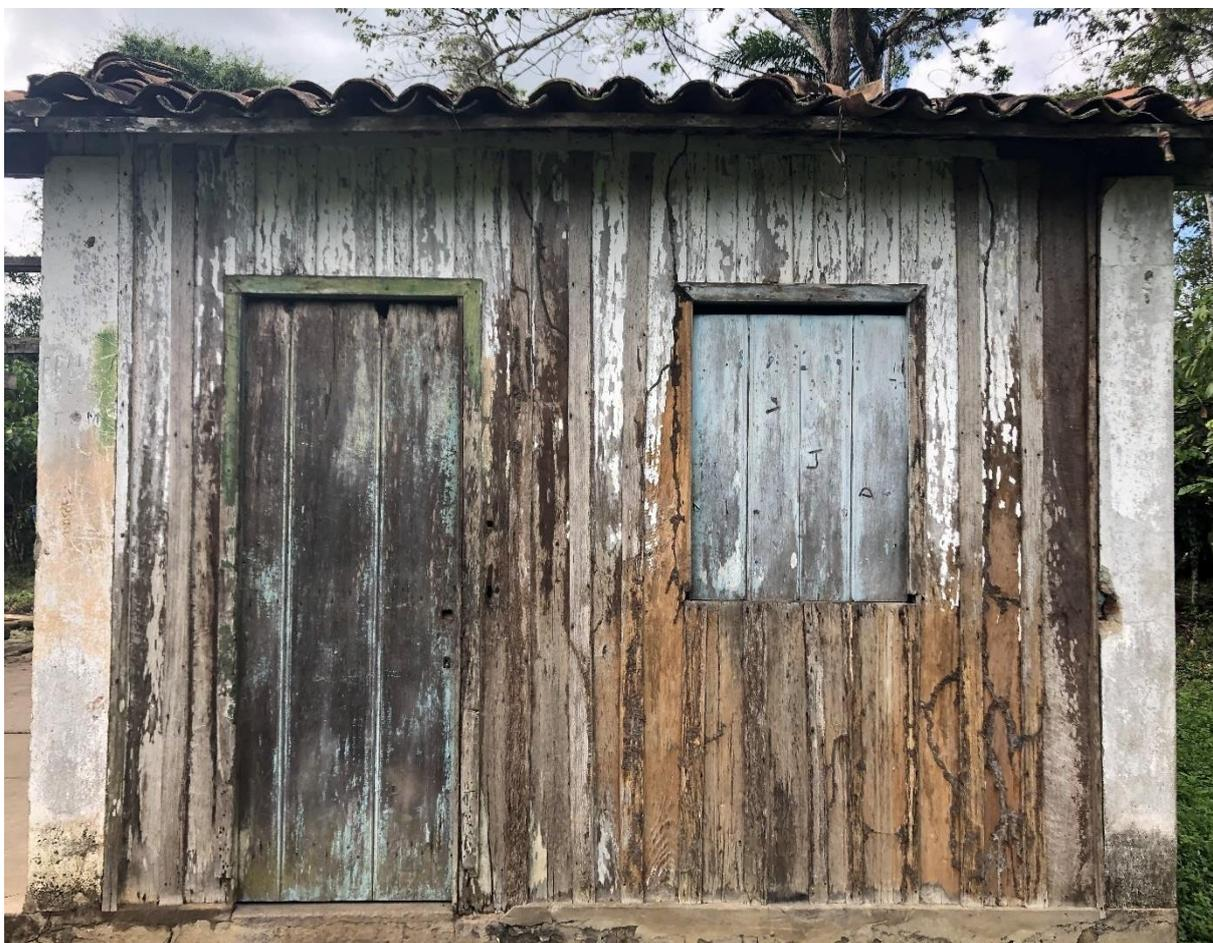
**Moradia destinada ao trabalhador █ e sua esposa. Paredes de madeira deterioradas, infestadas de cupins, telhados em péssimas condições de conservação e estruturas comprometidas**
