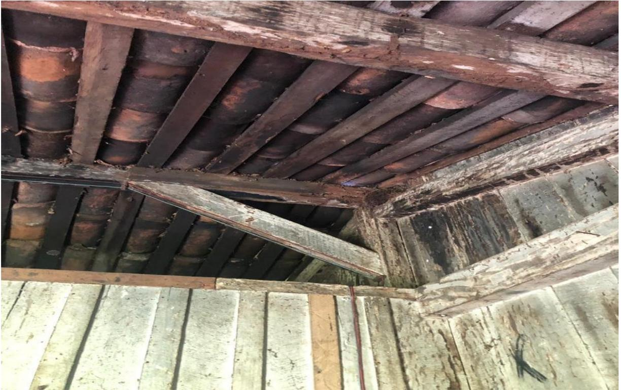
**Estrutura de sustentação dos telhados corroídas por cupins**
