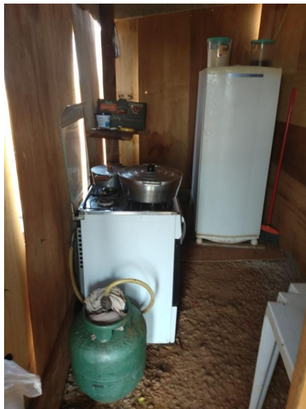
VISÃO COMPARATIVA DAS COZINHAS – BOTIJÃO DE GLP DENTRO DE UM DOS ALOJAMENTOS
