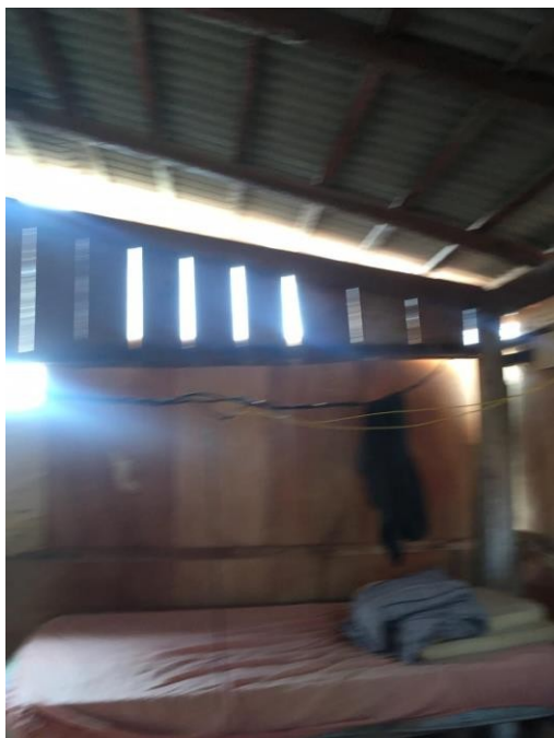
INEXISTÊNCIA DE PROTEÇÃO CONTRA INTEMPÉRIES E INSTALAÇÕES ELÉTRICAS PRECÁRIAS
