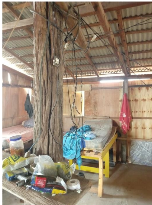
INEXISTÊNCIA DE PROTEÇÃO CONTRA INTEMPÉRIES E INSTALAÇÕES ELÉTRICAS PRECÁRIAS
