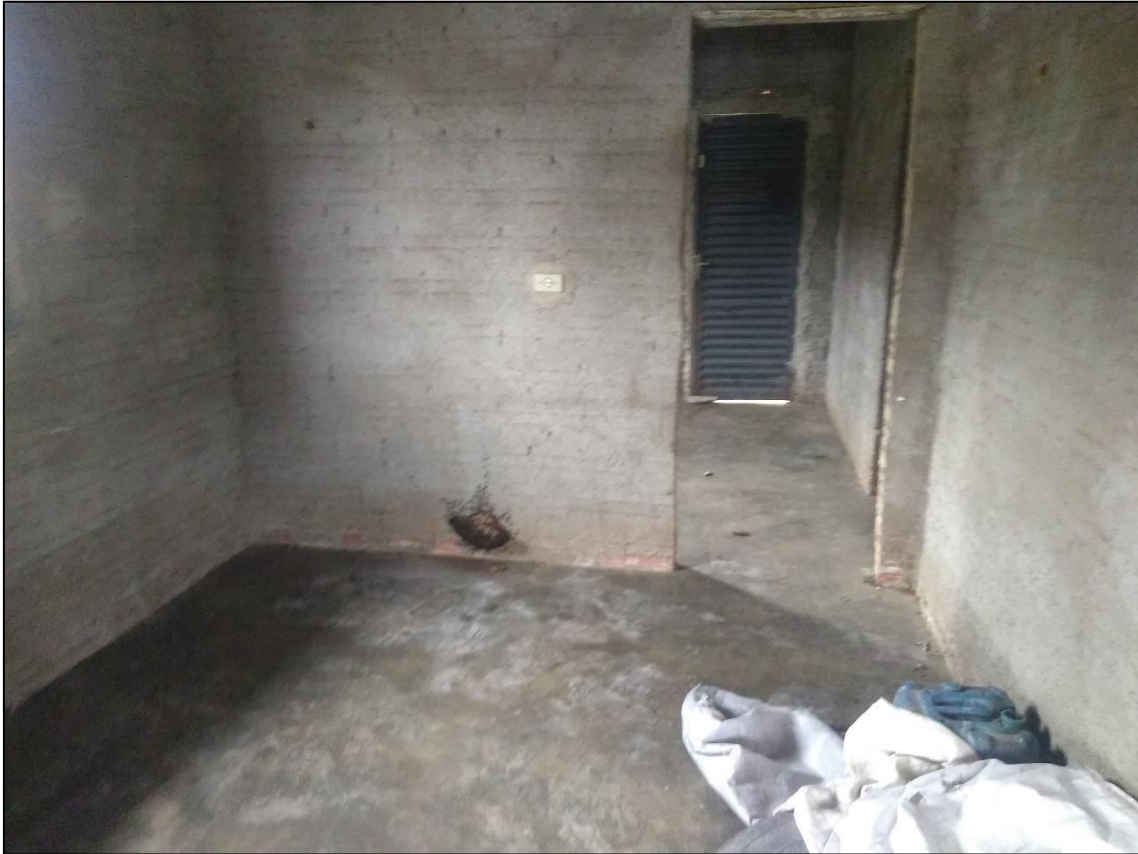
Foto 3: local inspecionado, alojamento sem utilização.
