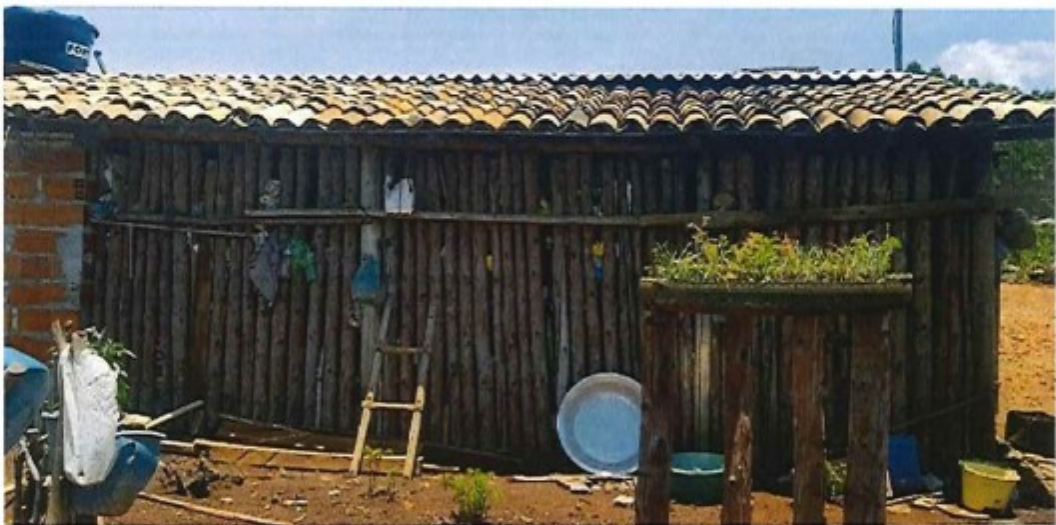
Alojamento - vista fundos
