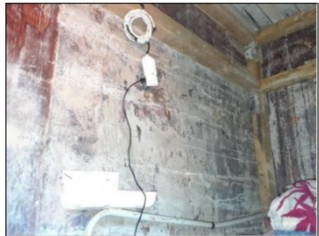
Fotos: Fiações elétricas do quarto onde pernoitavam quatro trabalhadores. Os riscos de choques eram iminentes.
