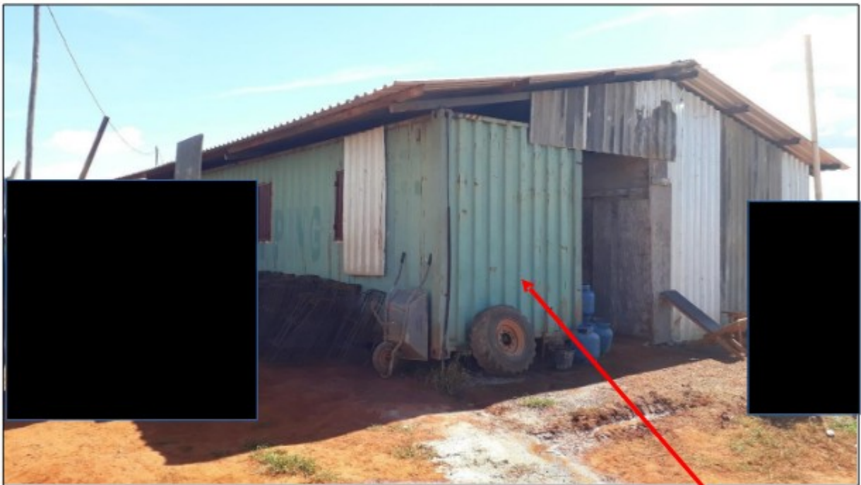
Foto: Áreas de vivência que eram utilizadas pelos trabalhadores da obra. Um dos dormitórios consistia em contêiner improvisado.
