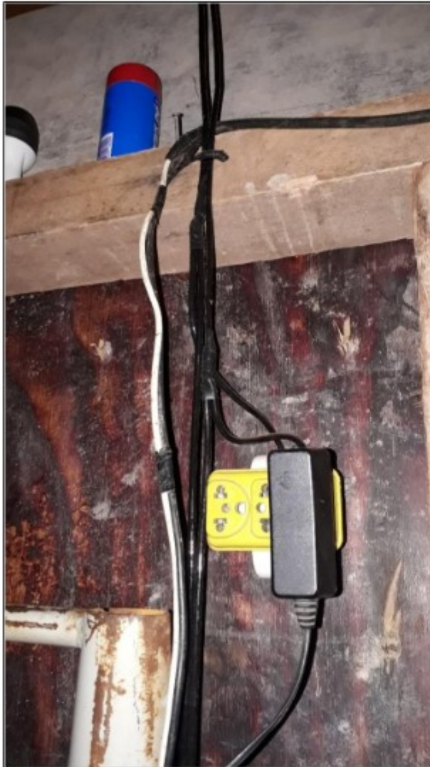
Fotos: Fiações elétricas do quarto onde pernoitavam quatro trabalhadores. Os riscos de choques eram iminentes.
