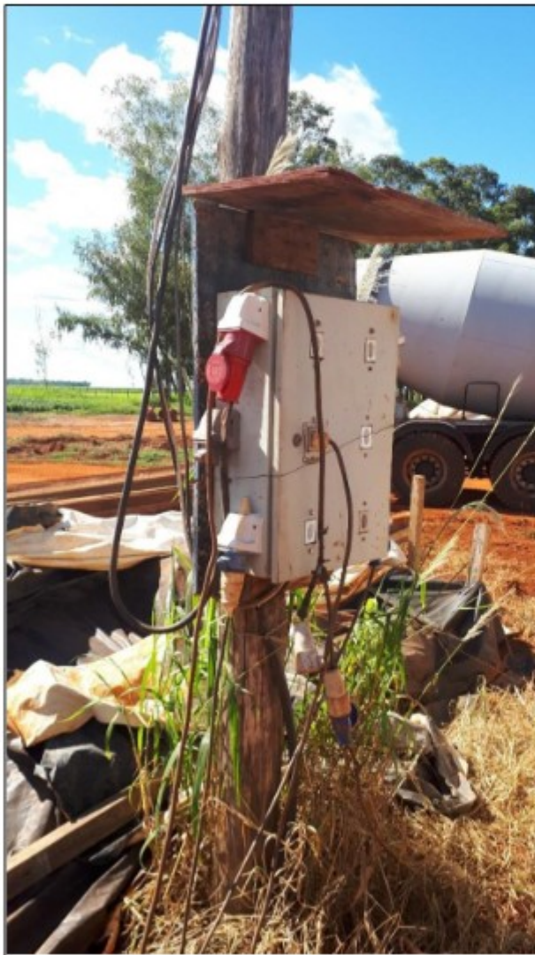
Fotos: Cabeamento elétrico que partia de uma caixa de distribuição de tomadas.
