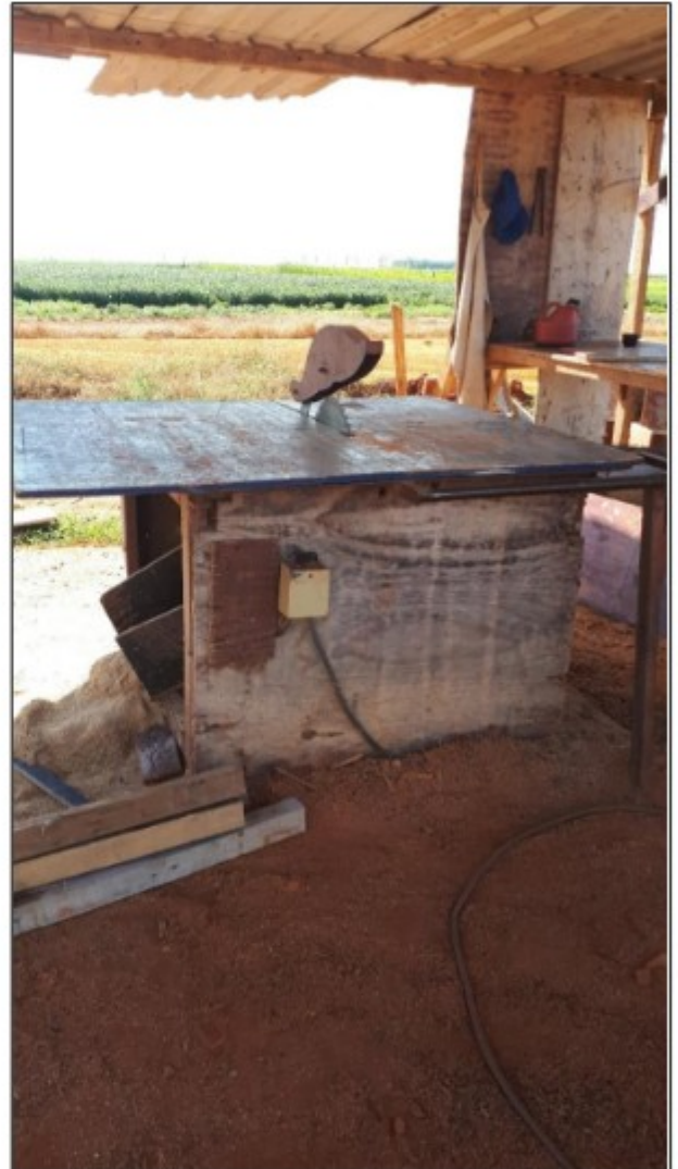
Fotos: Cabeamento elétrico da serra circular, sem qualquer proteção e solto no piso do setor de carpintaria da obra.
