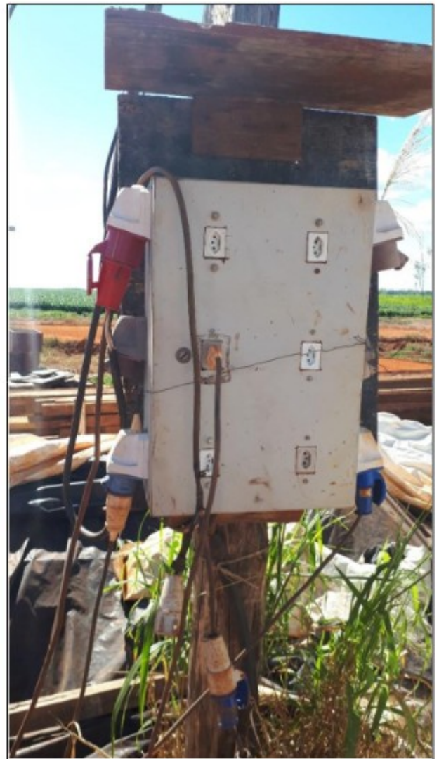
Fotos: Cabeamento elétrico que partia de uma caixa de distribuição de tomadas.
