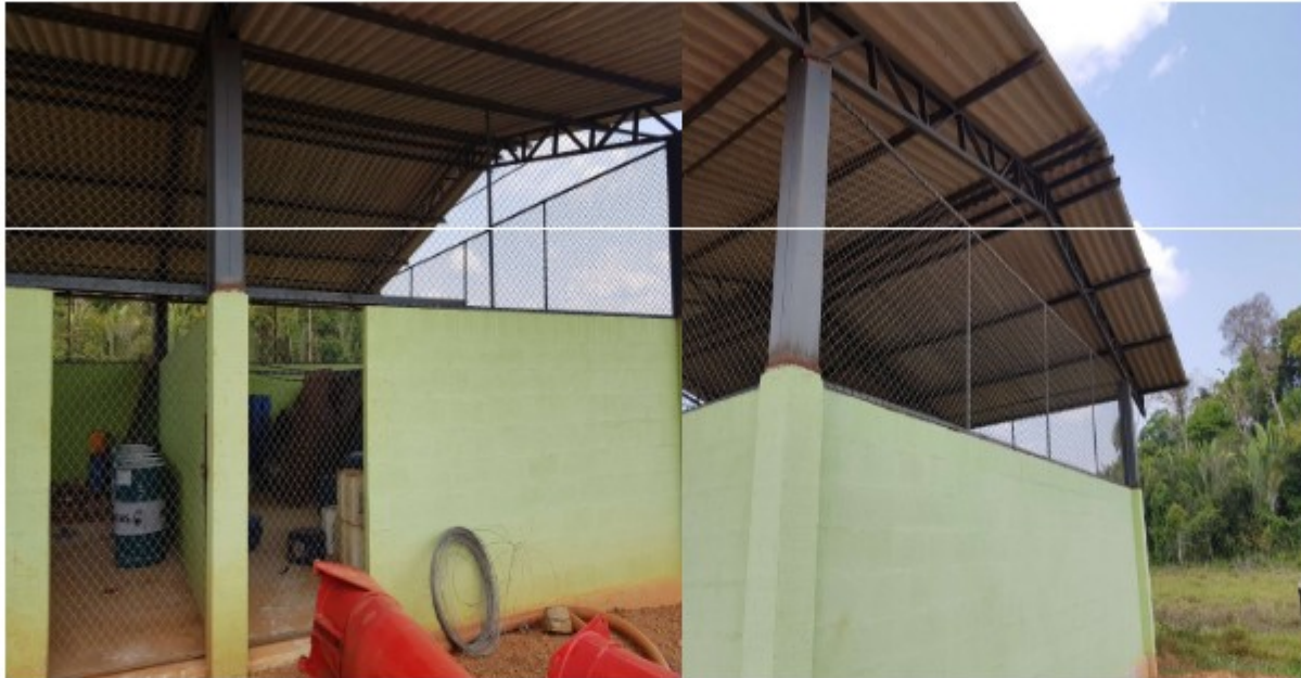
Figuras 16 e 17: Frente e um dos lados da edificação destinada ao armazenamento de agrotóxicos.
