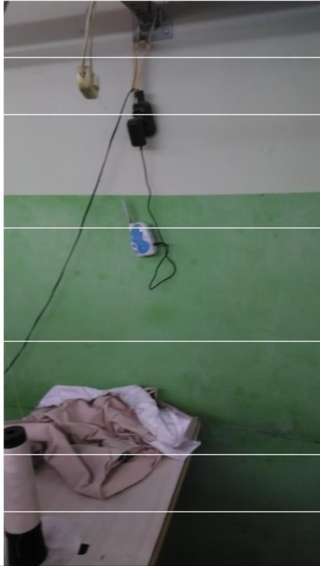
06/05/2019 - [REDACTED] **Ligações elétricas improvisadas no setor produtivo.** Desconformidade com a Norma Regulamentadora 10 – Segurança em Instalações e Serviços em Eletricidade e com a Norma Brasileira NBR 5410/1995 – Instalações Elétricas de Baixa Tensão.
