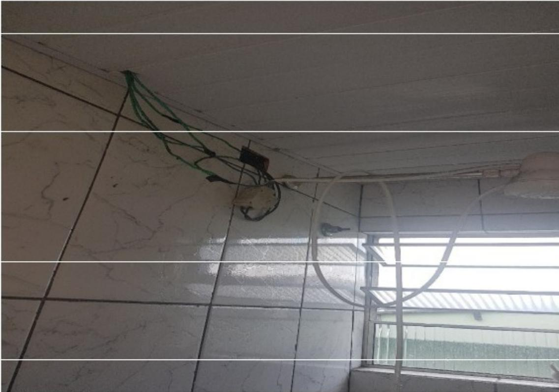
06/05/2019 – [REDAZIDA] **Ligações elétricas improvisadas no setor produtivo.** Desconformidade com a Norma Regulamentadora 10 – Segurança em Instalações e Serviços em Eletricidade e com a Norma Brasileira NBR 5410/1995 – Instalações Elétricas de Baixa Tensão.
