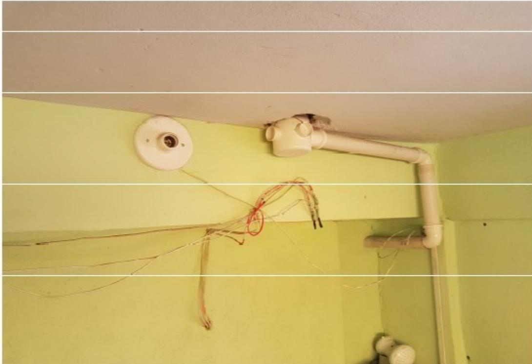
06/05/2019 – [REDAZIDA] **Ligações elétricas improvisadas no setor produtivo.** Desconformidade com a Norma Regulamentadora 10 – Segurança em Instalações e Serviços em Eletricidade e com a Norma Brasileira NBR 5410/1995 – Instalações Elétricas de Baixa Tensão.
