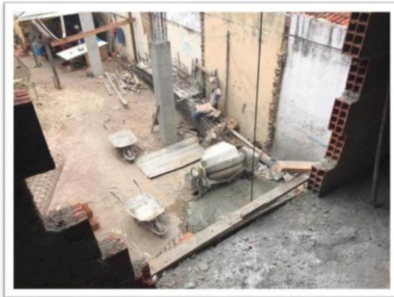
Figura 8 - Local de transporte de materiais entre o térreo e as lajes do edifício em construção.
