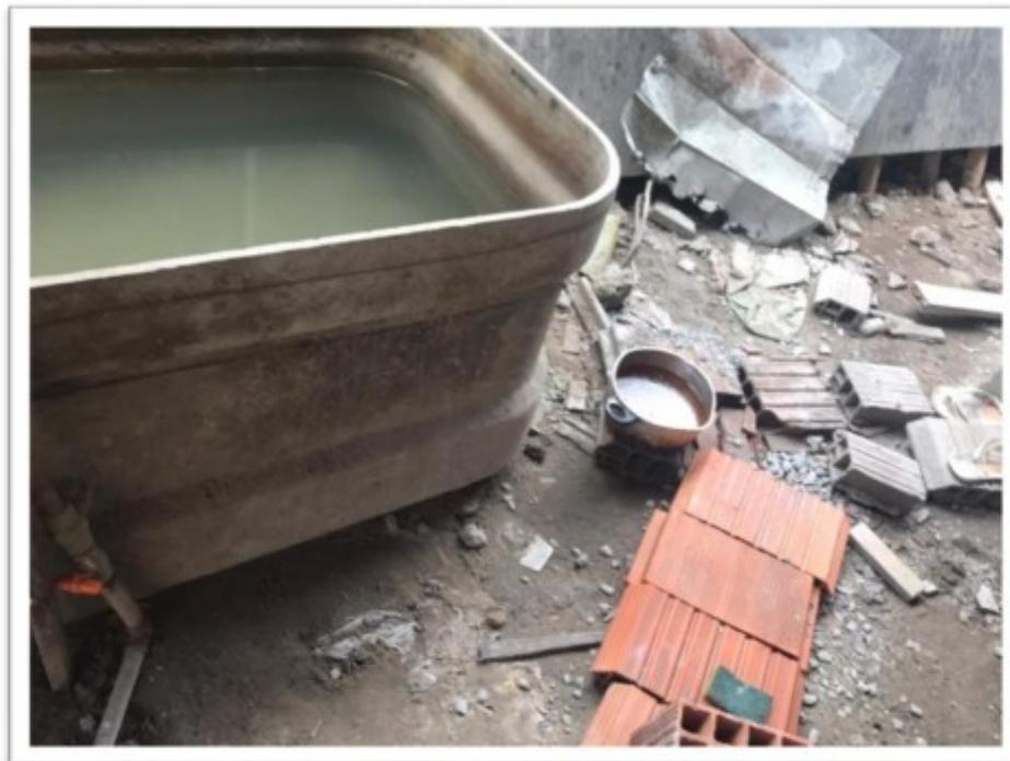
Figura 4 - Água utilizada para consumo humano, lavagem dos utensílios da cozinha e cozimento de alimentos, asseio das instalações sanitárias; e apresentando sujeira de material de construção devido sua exposição ao ambiente de trabalho sem nenhum tipo de proteção.
