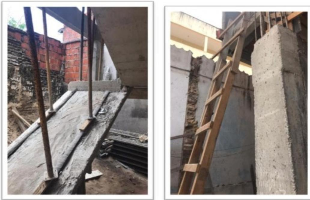
Figura 7 - Rampa e escada de acesso as lajes
