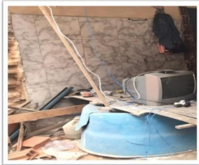
Figura 6 - Gambiarras elétricas por todo o canteiro de obras. Ex: Local de refeições e de lazer
