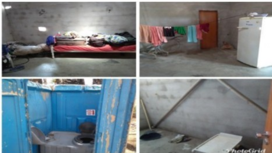
Fotos de cima: interior do alojamento; foto abaixo (esquerda): banheiro químico externo ao alojamento; foto abaixo (direita): banheiro em reforma.
