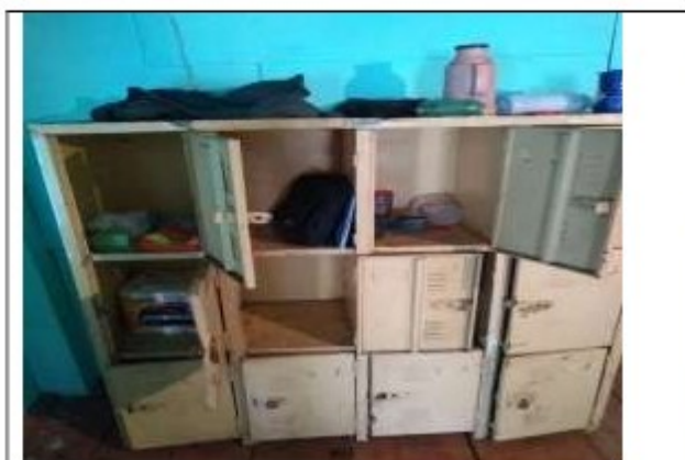
Armários em péssimo estado de conservação
