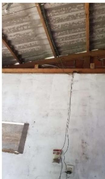
Fotos 6 e 7: instalação elétrica desprotegida da residência destinada ao trabalhador.
