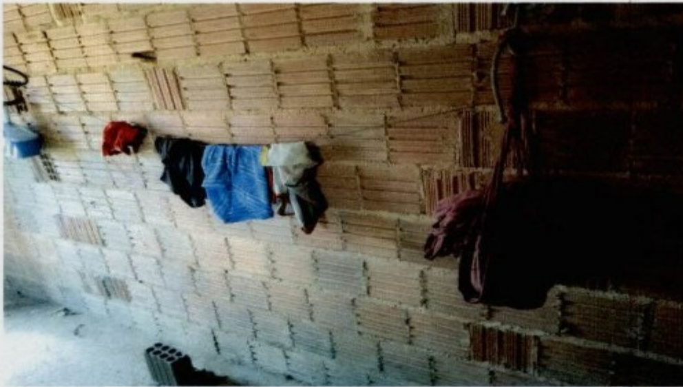
Foto acima: alojamento dos trabalhadores
