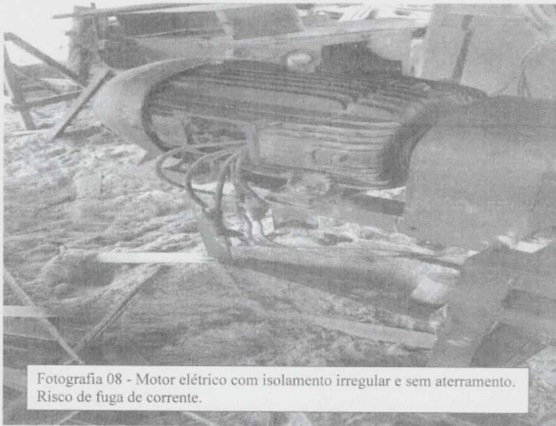
Fotografia 08 - Motor elétrico com isolamento irregular e sem aterramento. Risco de fuga de corrente.
