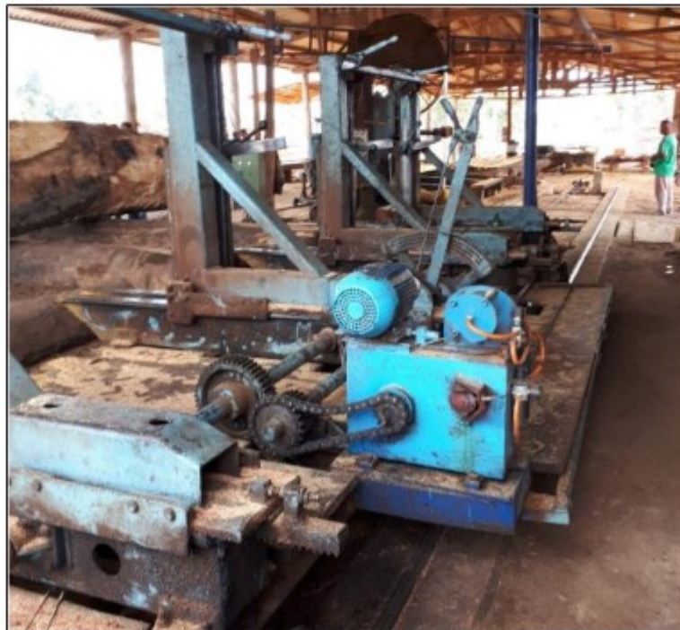
Foto: Áreas de circulação no interior da Serraria, sem demarcação de segurança.
