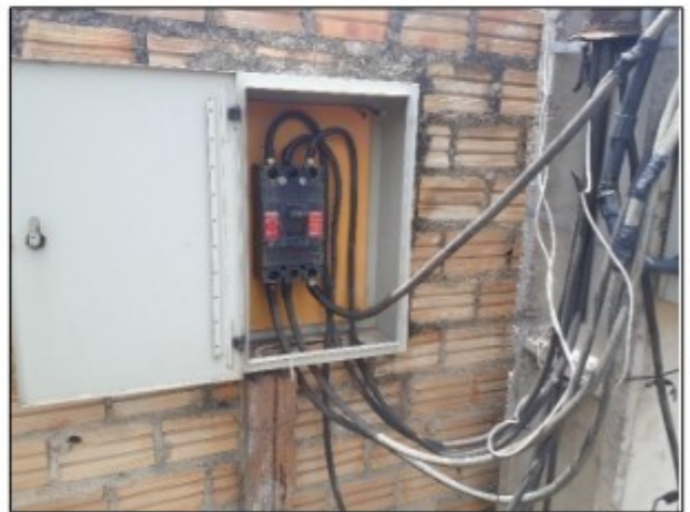
Fotos: Instalações elétricas que acarretavam riscos de choques e outros acidentes.
