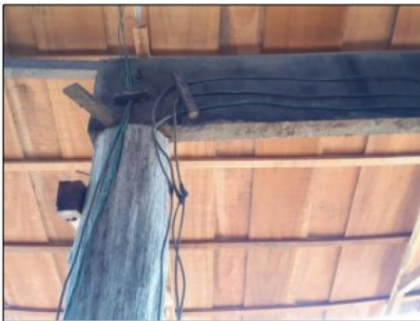
Fotos: Instalações elétricas que acarretavam riscos de choques e outros acidentes.
