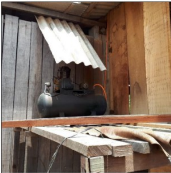
Fotos: Vaso de pressão instalado sem os requisitos legais de segurança determinados pela NR 13.
