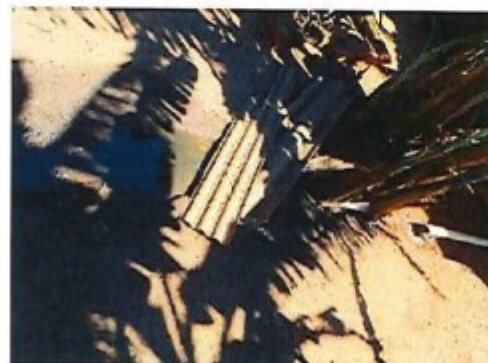
Esgoto a céu aberto nas imediações do barraco
