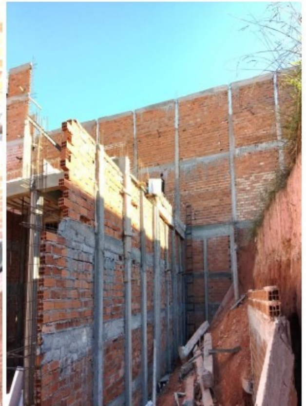
Fotos 37 a 40 – Vários locais na obra sem proteção coletiva, com riscos de acidentes, principalmente por queda, a exemplo das periferias das lajes, as quais não dispunham de nenhuma proteção contra quedas.
