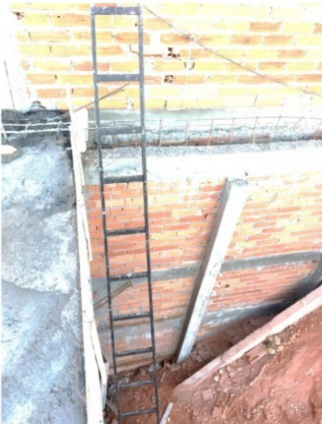
Fotos 37 a 40 – Vários locais na obra sem proteção coletiva, com riscos de acidentes, principalmente por queda, a exemplo das periferias das lajes, as quais não dispunham de nenhuma proteção contra quedas.
