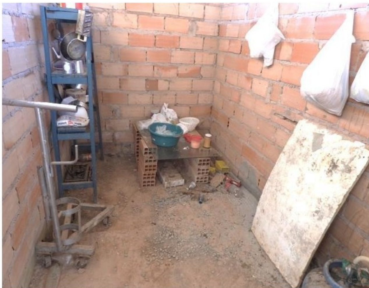
Fotos 11 a 13 – Cozinha improvisada para os operários aquecerem as refeições que traziam de casa (marmitas), preparadas no dia anterior.
