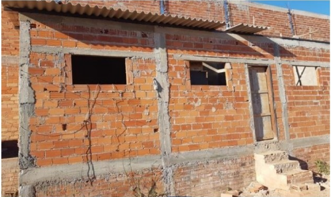
Foto 3 - Local usado com o alojamento pelo empregado J. Tratava-se de um a sala da obra em construção.
