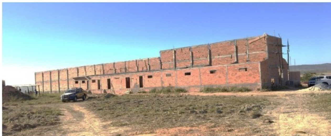
Foto 1- Vista externa do canteiro de obras de construção das futuras instalações do Frigorífico Serra Dourada
