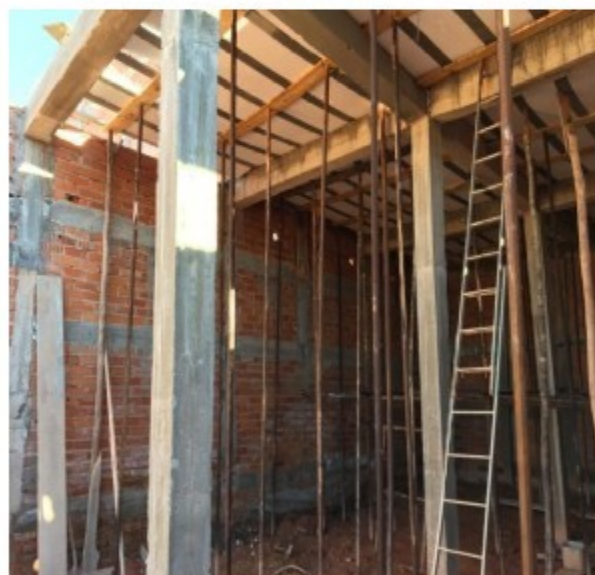
Fotos 47 a 50 – Vários pontos com aberturas no piso de fechamento provisório resistente, com risco de acidentes por queda do trabalhador.
