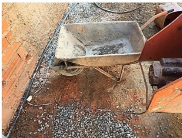
Fotos 41 e 42 – betoneira com ligação elétrica direta dos cabos de força à rede elétrica externa, sem chaves, disjuntores ou botoeiras
