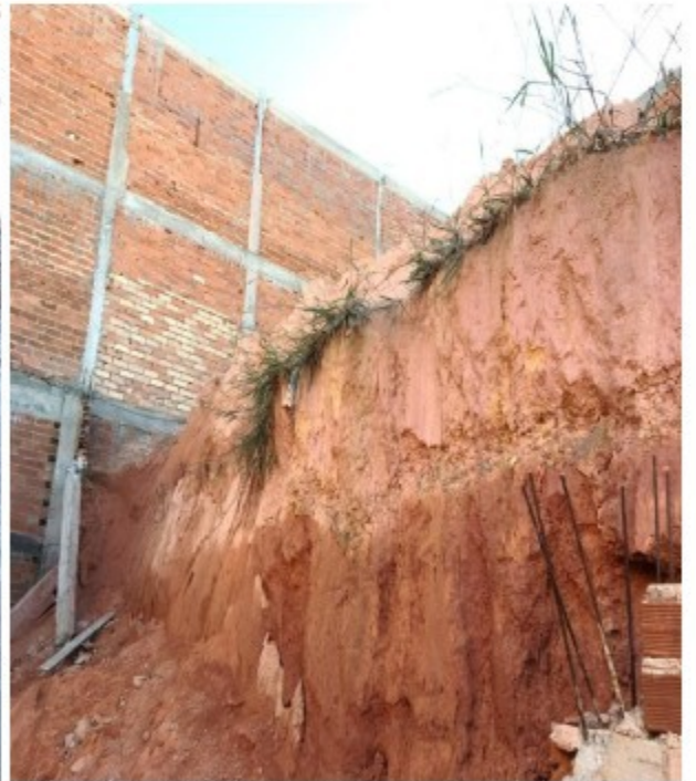
Fotos 29 a 32 – Materiais retirados da escavação, depositados a uma distância inferior à metade da profundidade, medida a partir da borda do talude, gerando riscos de desabamento.
