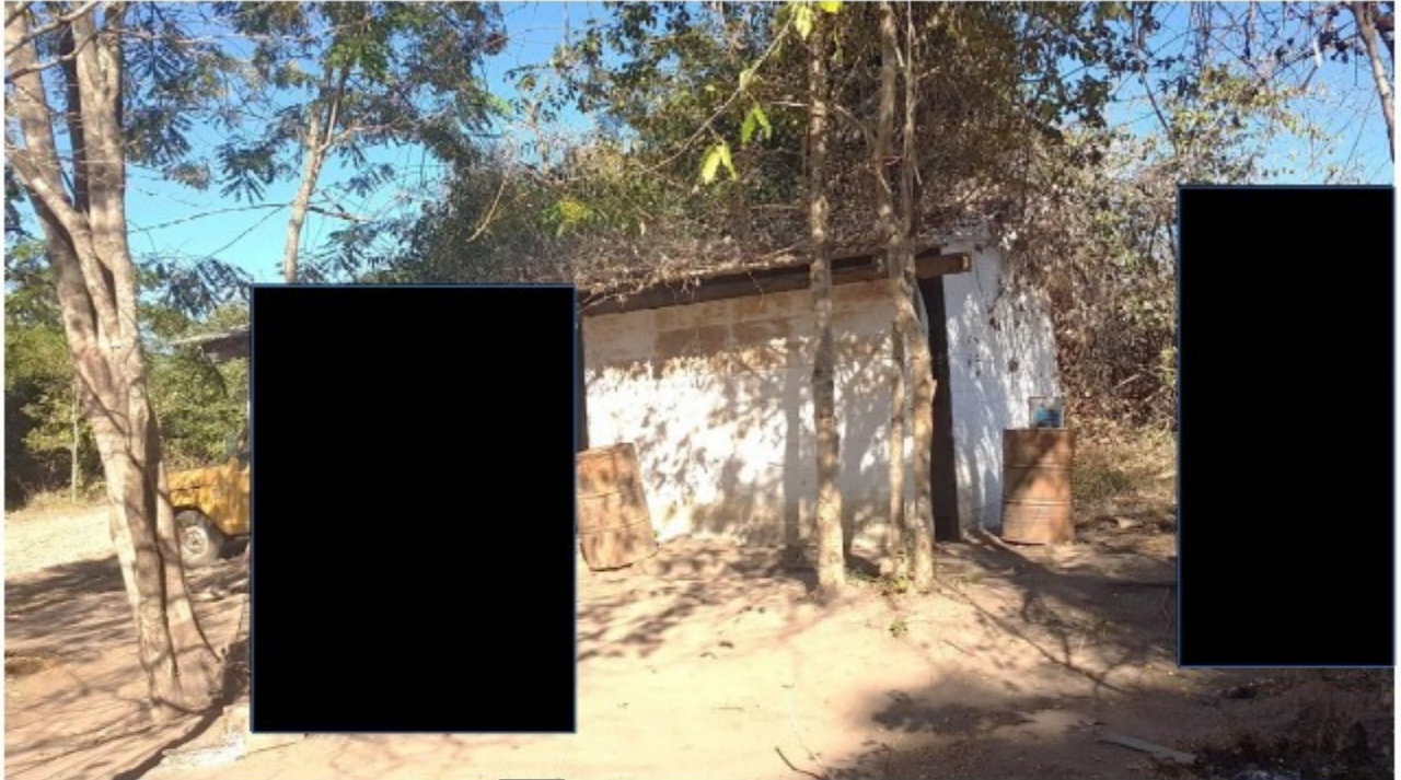
Foto 10 – Barraco onde o trabalhador e sua esposa estavam alojados e, às vezes, também o Sr. D.
