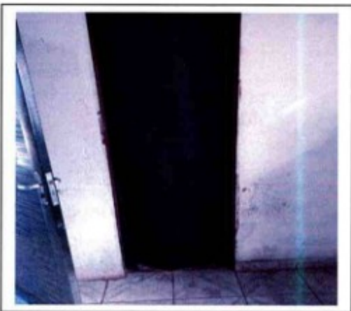
Porta da instalação sanitária fechada com cortina.
